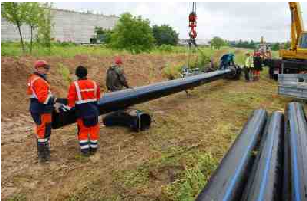
Процес заміни частини водопровідних мереж
