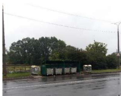
Фото. Облаштований контейнерний майданчик недостатньої місткості
