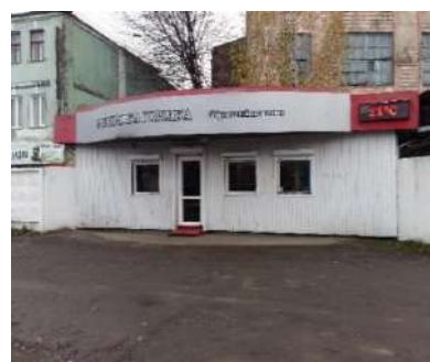
Фото. Відсутність урн при вході до закладів торгівлі
