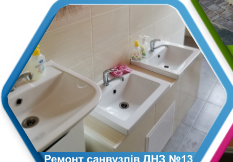
Ремонт санвузлів ДНЗ №13 ініціатива - Романюк М.
